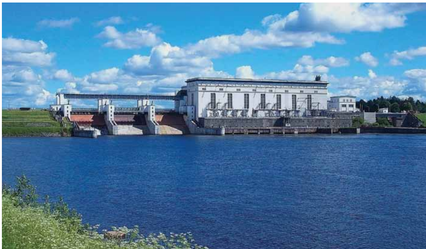
Верхнесвирская ГЭС в городе Подпорожье
